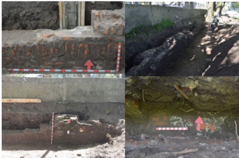
Figura 6: Arriba a la izquierda, construcción de pilar, sector original y limpio para la reconstrucción (carpeta 12/10/2018). Abajo a la izquierda, muro IV, pilar previo a la reconstrucción (carpeta 12/10/2018). Arriba a la derecha, excavación y muro III previo a la reconstrucción (carpeta 12/10/2018). Abajo a la derecha, patín al lado norte del muro (carpeta 12/10/2018).
