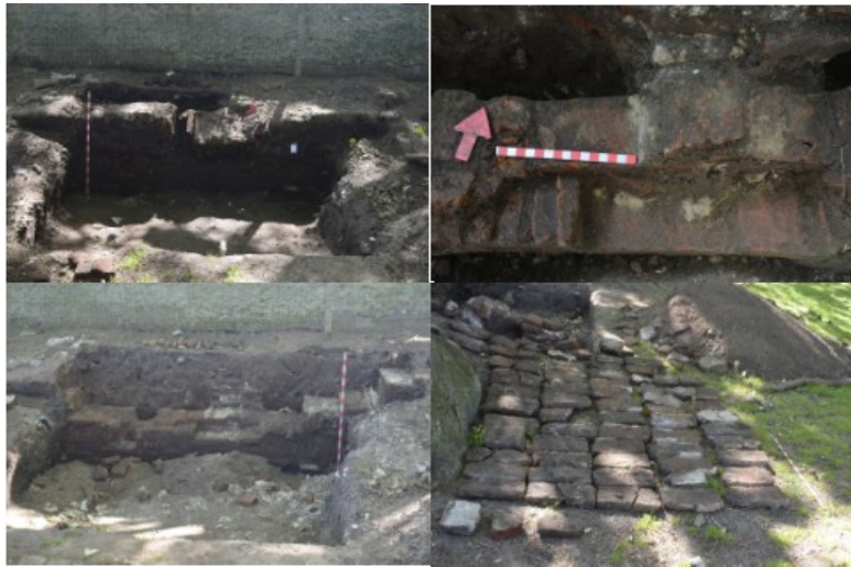
Figura 7: Arriba a la izquierda, muro IV previ3 al desmonte (carpeta 12/10/2018). Abajo a la izquierda, luego del desarme (carpeta 12/10/2018). Arriba a la derecha, extracci3n y limpieza de pilar original a reconstruir (carpeta 12/10/2018). Acumulaci3n de ladrillos extra3dos del muro (carpeta 12/10/2018).
