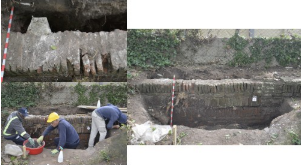
Figura 5: Muro II, arriba a la izquierda excavación sector norte (carpeta 12/10/2018). Abajo a la izquierda, trabajo de ingreso de argamasa en muro (carpeta 08/11/2018). Derecha, excavación II (carpeta 12/10/2018).
