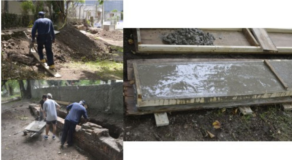
Figura 19: Arriba a la izquierda, creación de terraplén junto al muro I (carpeta 08/11/2018). Abajo a la izquierda, combinación de tierra, portland y pedregullo para rellenar el sector norte del muro (carpeta 12/12/2018). Derecha, creación de lozas para poner en la superficie del muro (carpeta 12/12/2018).
