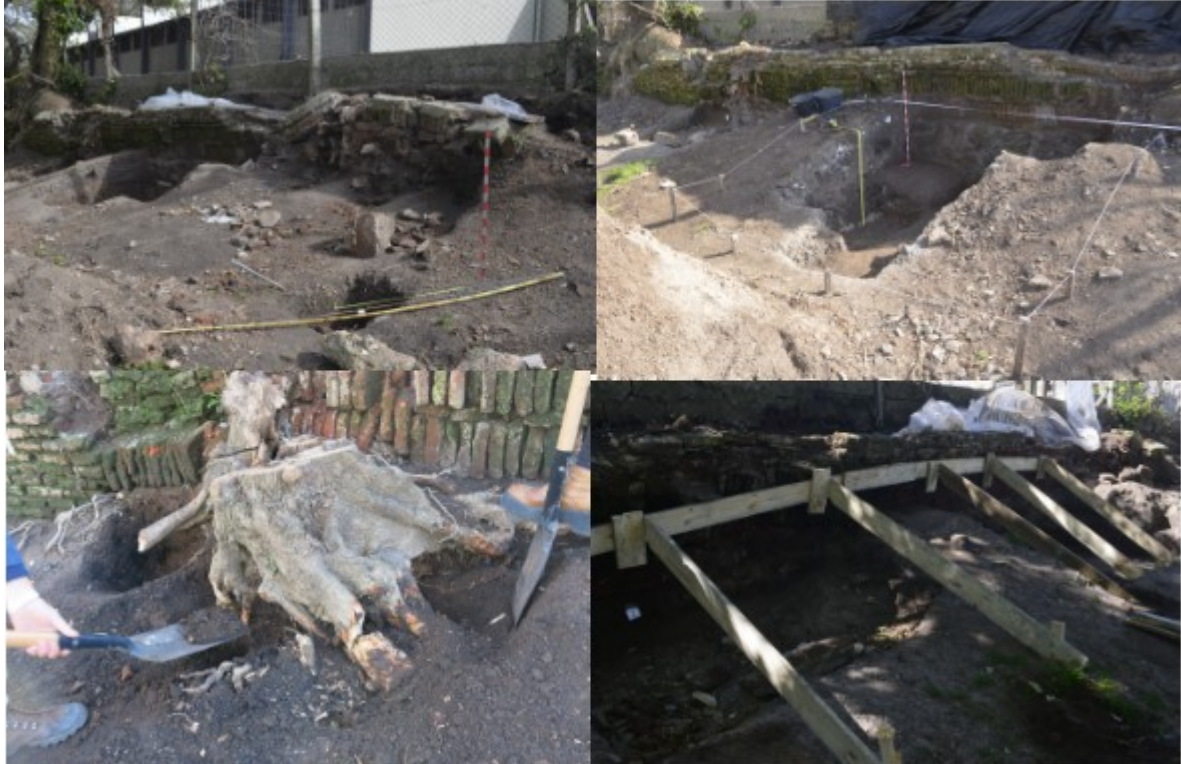
Figura 1: Arriba a la izquierda, condición del muro I previo a ser recuperado (carpeta 24/09/2018). Abajo a la izquierda, se extraen cinco árboles de raíz del género Myoporum llamados socialmente Transparente. Arriba a la derecha, excavación arqueológica que permitió hallar al muro perimetral sur. Abajo a la derecha se apuntaló el muro I, buscó evitar derrumbes de los sectores con mayor intemperismo al momento de excavar su lado norte.
