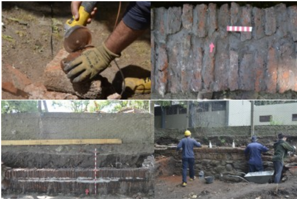
Figura 17: Arriba a la izquierda se corta con amoladora los ladrillos paridos para ser introducidos en el muro (carpeta 13/11/2018). Abajo a la izquierda, muro V con una fila de ladrillos horizontales y verticales introducidos (carpeta 13/11/2018). Arriba a la derecha, ladrillos cortados con amoladoras introducidos en el muro (carpeta 13/11/2018). Trabajo en el muro I (carpeta 13/11/2018).
