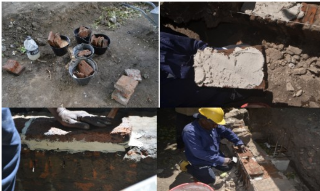
Figura 14: Arriba a la izquierda, se humedecen los ladrillos, previo a rociar con Sika Top modul en estado líquido (carpeta 08/11/2018). Abajo a la izquierda, ladrillos horizontales se cementan con argamasa de cal y arena (carpeta 08/11/2018). Arriba a la izquierda, argamasa en ladrillo (carpeta 08/11/2018). Abajo a la derecha, cementación de ladrillos horizontales (carpeta 08/11/2018).
