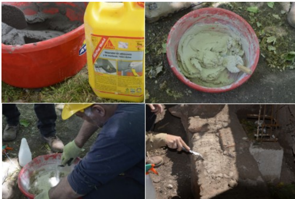
Figura 11: Arriba a la izquierda, SikaTop Modul y argamasa de tierra tamizada preparada (carpeta 08/11/2018). Preparación de argamasa de cal y arena (carpeta 08/11/2018). Arriba a la derecha argamasa de cal y arena preparada (carpeta 08/11/2018). Abajo a la derecha limpieza de superficie mural para incertar argamasa (carpeta 08/11/2018).
