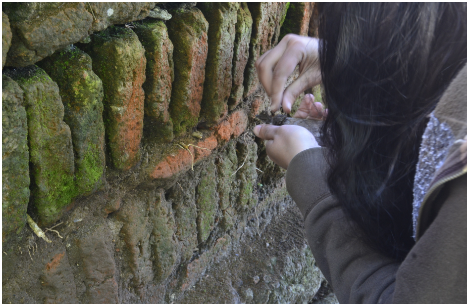
Figura 12: Toma de muestras de argamasa para ser analizada en el laboratorio (carpeta 12/10/2018).
