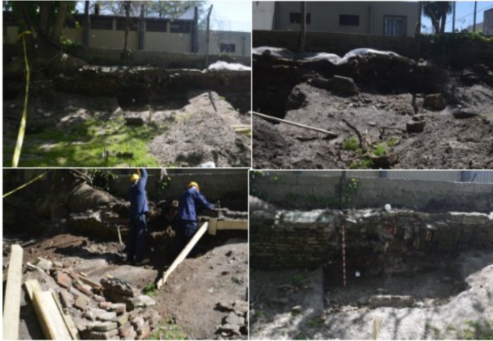
Figura 3: Arriba a la izquierda, trinchera 2 previó derrumbé (carpeta 12/10/2018). Arriba a la derecha, muro I previó desarme (carpeta 12/10/2018). Abajo a la derecha, previó al derrumbe (carpeta 12/10/2018). Abajo a la izquierda, Al excavar el sector norte del muro para colocar el nuevo pilar, se derrumba es sector del muro donde se realizó la trinchera 2, en el muro I será cubierto por terraplén de tierra. Acumulación de ladrillos que serán reutilizados (carpeta 12/10/2018).
