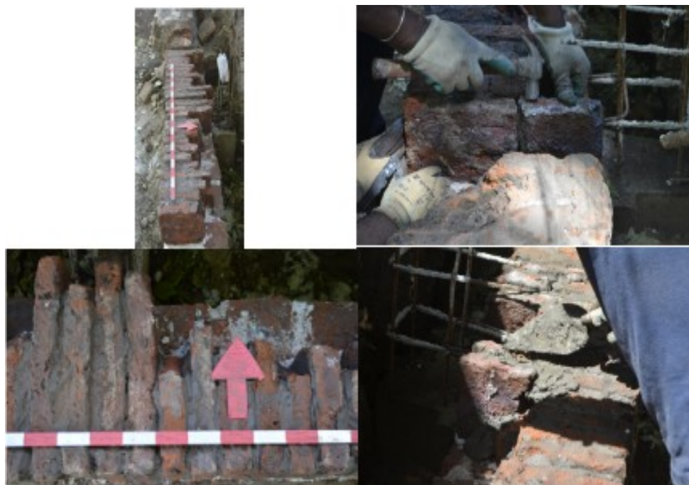
Figura 16: Ladrillos horizontales cimentados con argamasa de tierra y portland, los ladrillos están partidos y se fueron unificando a medida que se realizaba la fila vertical, se ve a los estribos ingresar en los ladrillos verticales para evitar el derrumbe (carpeta 08/11/2018).
