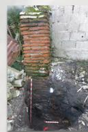
La trinchera 12 fue realizada sobre el pilar suroeste del muro perimetral del CRCF. Se pudo identificar una cimentación en piedra donde apoya el muro similar a la expuesta en el sector I.
